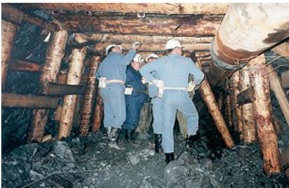
Podzemní pracoviště uranových dolů (Rožná I)
