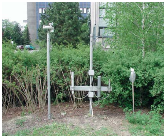
Obr. 1 - Měřicí místo SVZ a TLD sítě vybavené (zleva) měřicími stanicemi, proporcionálním detektorem, G-M detektorem a TL dozimetrem.
