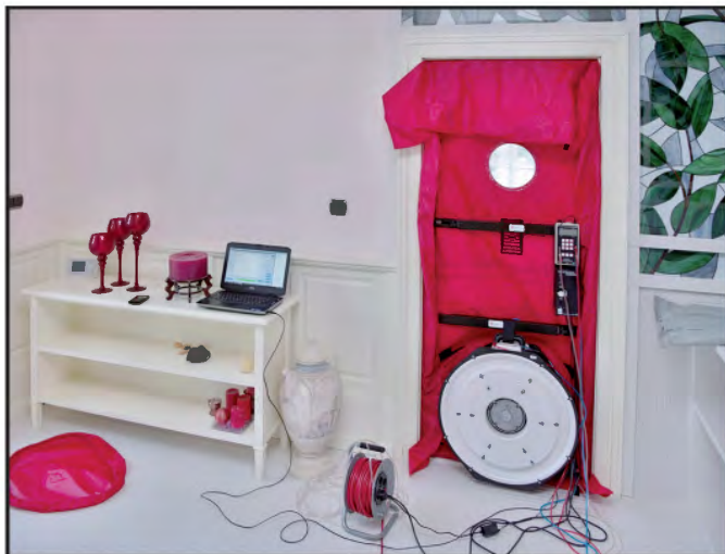
Pomocí Blower door testu lze při radonové diagnostice odhalit místa, kudy radon vstupuje do budovy
