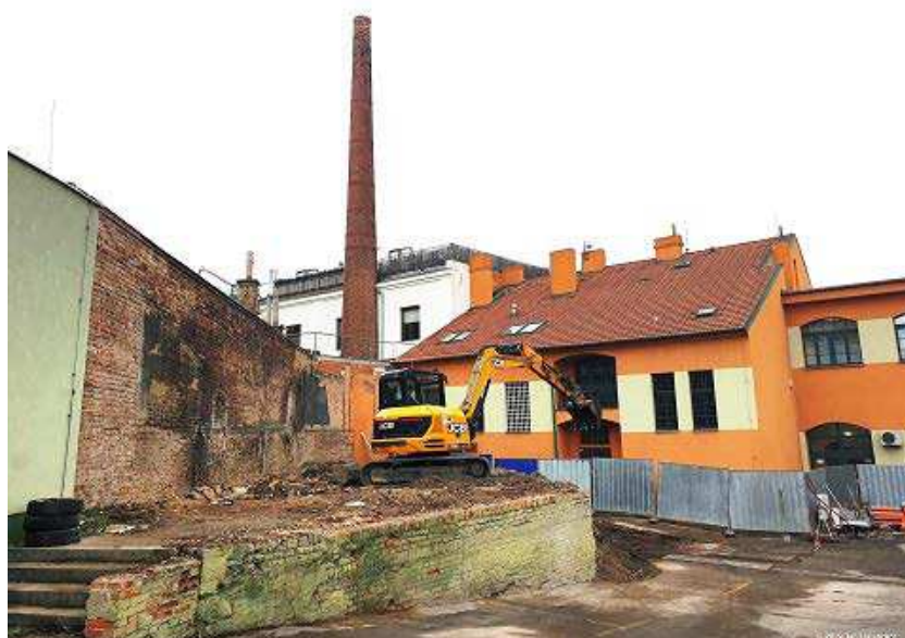
Obrázek 12: Ilustrační foto – výstavba nového objektu v areálu SÚRO Bartoškova
