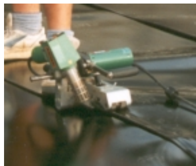
Obr. 19. Svařování HDPE fólie dvoustopým svarem se zkušebním kanálkem. Vlivem lokálního zvýšení teploty v místě sváru dochází k nevratnému zvlnění fólie.
